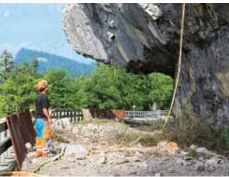
Wenn gefährliches Material vom Fels gelöst wird, schützen eine Sandschicht die Strasse und Stahlplatten die Leitplanken.
