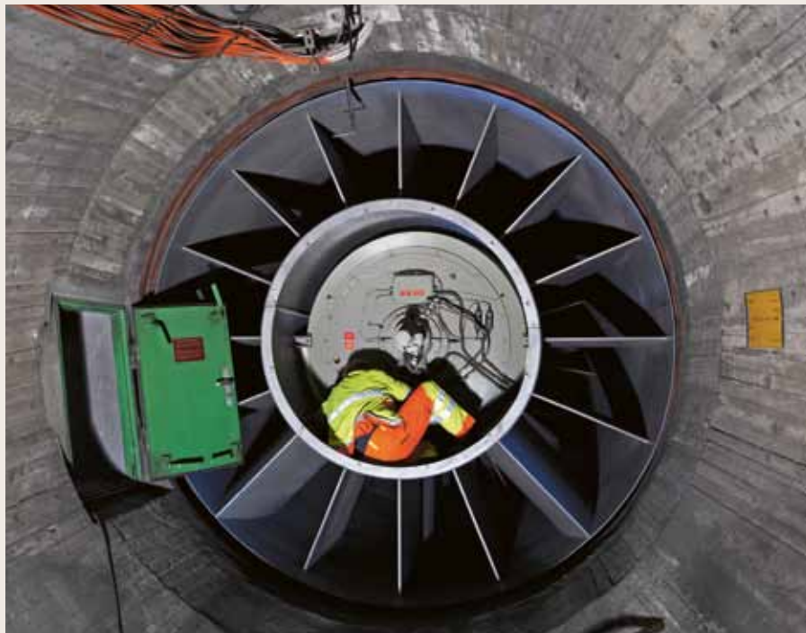
Fotos: Amt für Betrieb Nationalstrassen Kanton Uri
