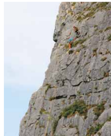
Es versteht sich von selbst, dass spezialisierte Bergsteiger die Felsräumung verrichten müssen.
